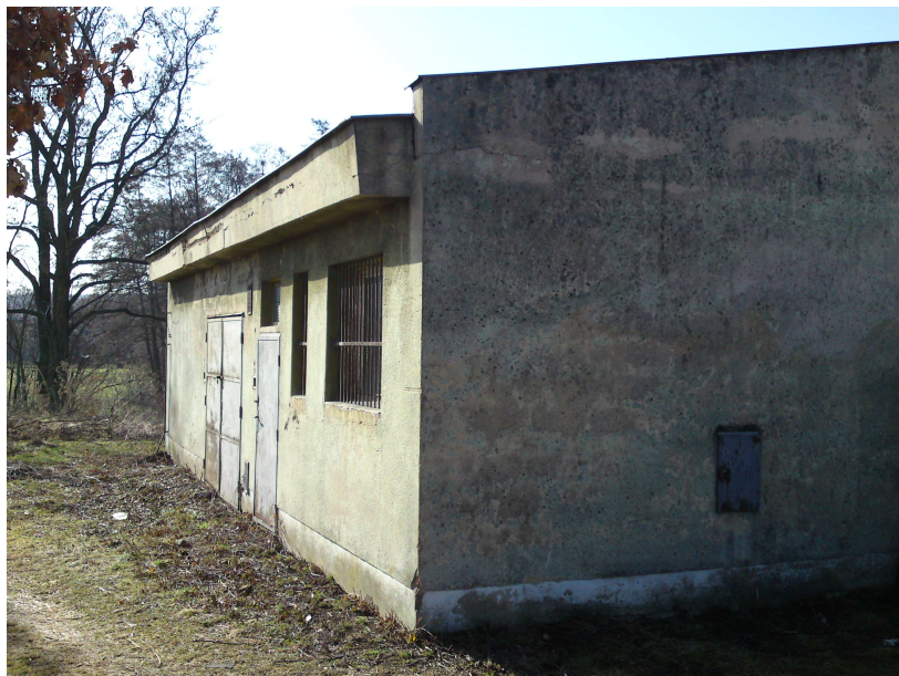
Vodárna obce Zlatá
